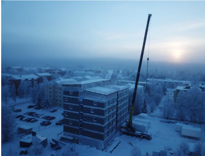
DAS Riihipellonpuisto, asennustyöt käynnissä. Kuva: Toni Kekki
